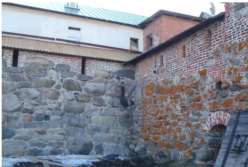
**Рисунок 2.** Угол между Поваренной башней и стеной. Часть стены с произрастающими на ней лишайниками и часть стены, где лишайники уничтожены
