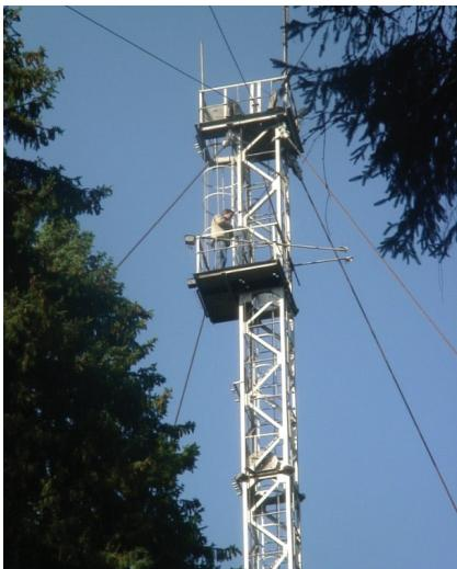
**Рисунок 2.2.** Верхняя часть мачты с установленным микрометеорологическим оборудованием (полигон «лог Таежный» ВФ ФГБУ
